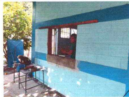
Foto 6: Se observa la pared que se abrió para la conformación de la ventana
