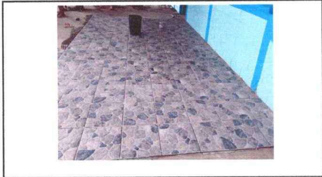
Foto 8: Se observa la colocación del piso cerámico
