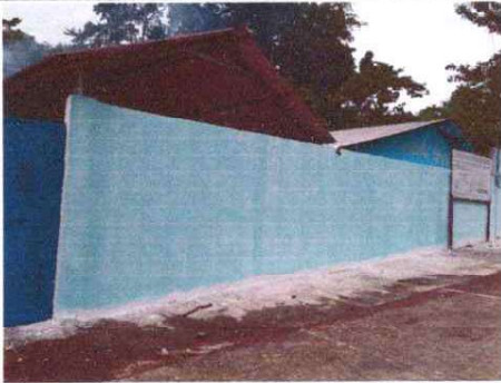
Foto 13: Se observa la aplicación de alisado y pintura en muros
