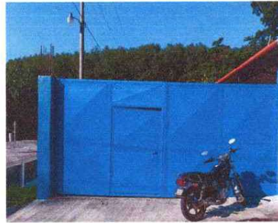
Foto 14: Se observa el mantenimiento del portón
