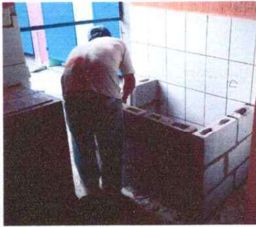
Foto 1: Se observa la realización de una estufa rural, la cual se colocó en este sitio.
