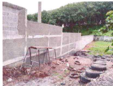
Foto 18: Se observa la aplicación de repello a los muros.
