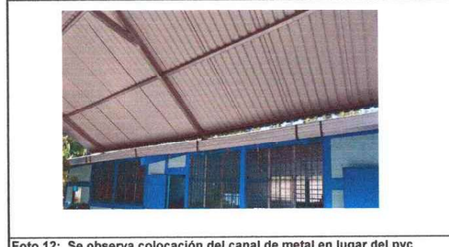
Foto 12: Se observa colocación del canal de metal en lugar del pvc
