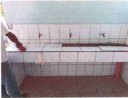
Foto 3: Se observa la creación del banco de cocina y el sistema eléctrico, se observa el sitio donde se colocará
