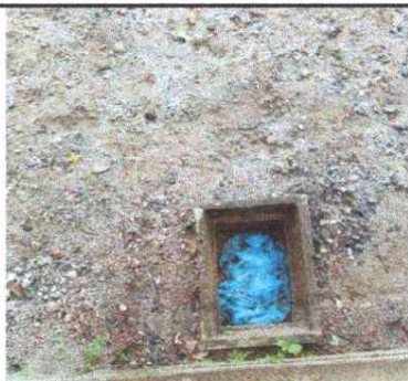
Foto 17: Se observa la necesidad colocacion de tapadera de caja
