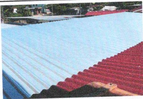
Foto 3: Terminación de la sustitución de láminas troquelada aluzinc calibre 26
