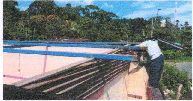
Foto 2: Se realizó la sustitución de estructura de soporte de metal por metal
