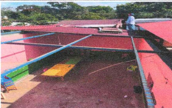
Foto 3: Se realizó la sustitución de lámina, por lámina troquelada aluzinc calibre 26
