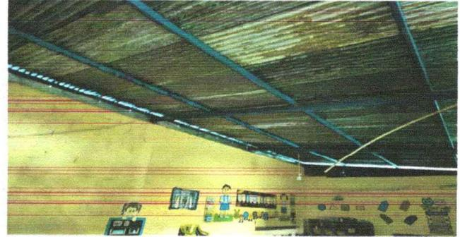
Foto 2: Se observa estructura de metal en mal estado
