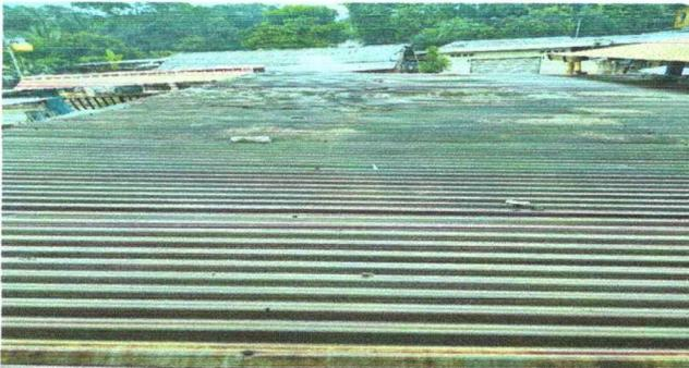
Foto 3: Se observa lamina en mal estado
