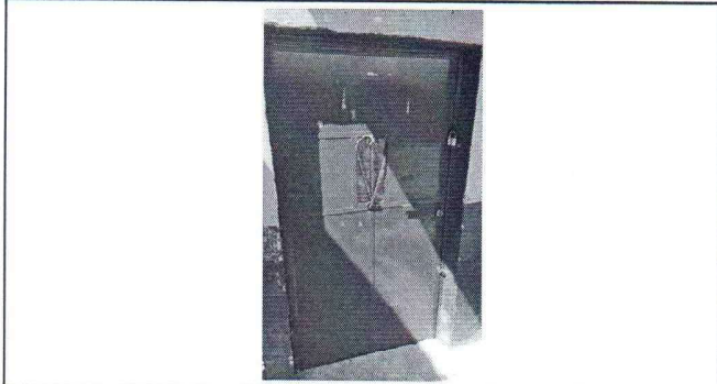
Foto 1: Se observa que las chapas de las puertas del módulo de aulas 1 no funcionan, se cierran utilizando un candado. Por lo que es necesario cambiarle las chapas.
