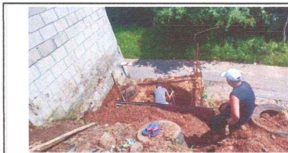
Foto 6: Se observa la colocacion del biodigestor
