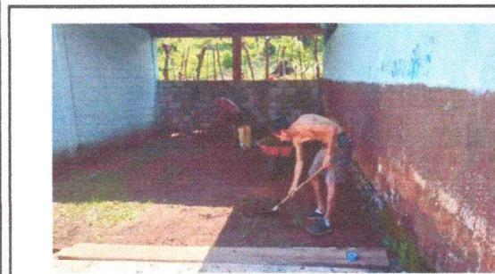
Foto 5: Se observa la conformacion de la torta de concreto
