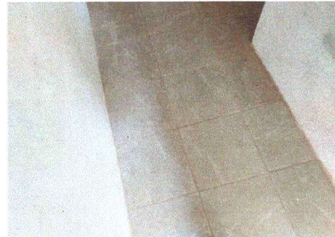
Foto 4: Se observva como quedo la colocacion de piso
