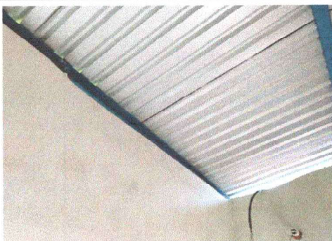
Foto 11: Se observa la lamina ya colocada
