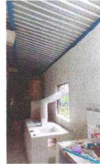
Foto 2: Se observa como quedo el muro
