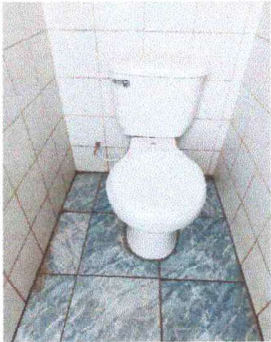
Foto 7: Se observa los sanitarios ya colocados
