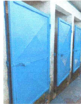
Foto 8: Se observa las puertas despues del mantenimiento
