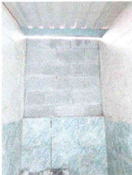
Foto 9: Se observa como quedo la reparacion del muro
