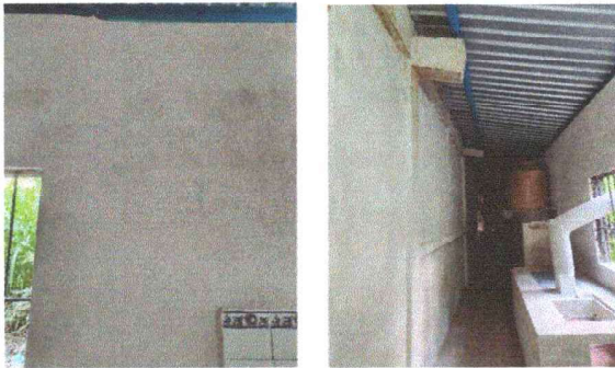
Foto 3: Se observa como quedo el repello en los muros
