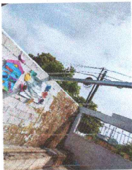
Foto 11: Se observa el cambio de lamina en mal estado
