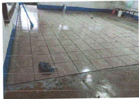
Foto 10: Se observa el cambio de piso
