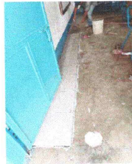
Foto 4: Se observva la colocacion de piso
