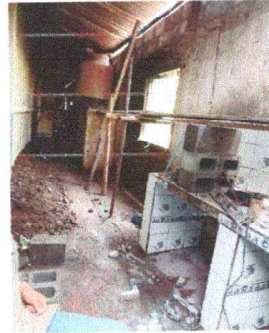
Foto 2: Se observa el muro en reparacion
