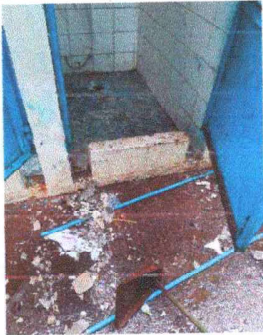
Foto 7: Se observa el cambio de los sanitarios
