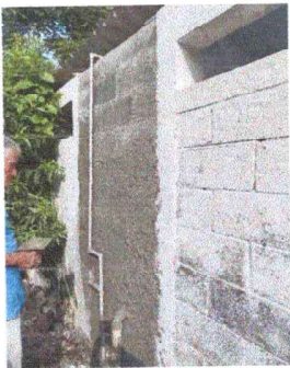
Foto 9: Se observa la reparación del muro
