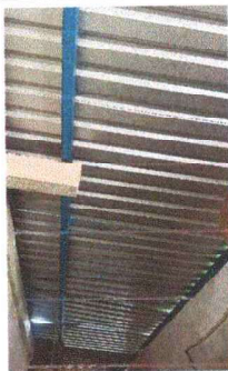
Foto 5: Se observa el cambio de lamina
