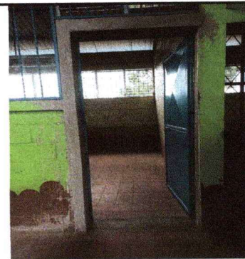
Foto 10: Colocación de puerta.
