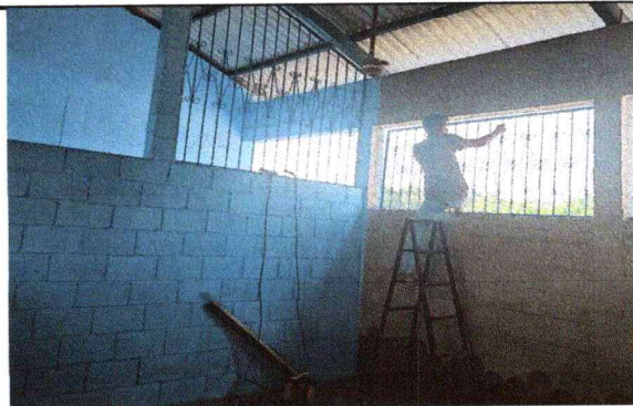
Foto 9: Se verifica la instalación de balconeado.
