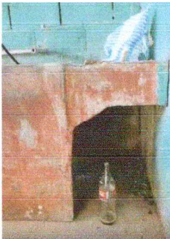
Foto 3: Proceso de cambio de pila
