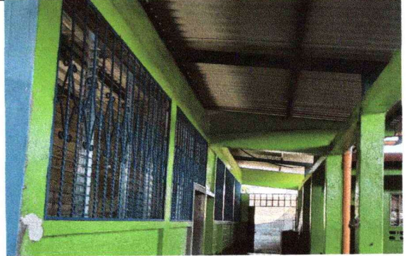
Foto 8: Instalación de ventanas de vidrio tipo paleta
