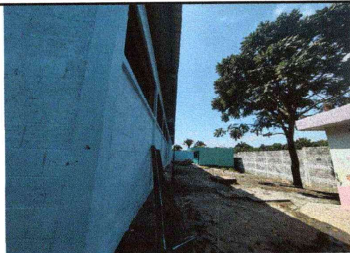
Foto 11: Proceso de pintura en pared exterior.
