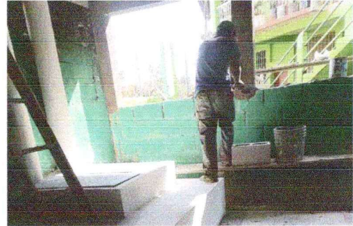
Foto 2: Proceso de conformación de ventana en cocina
