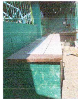
Foto 4: Proceso de instalación de azulejo
