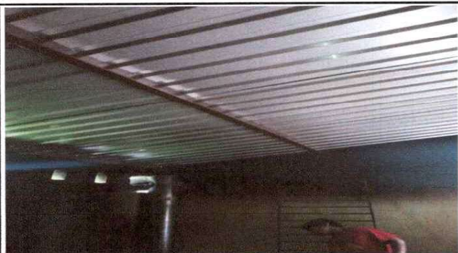
Foto1: Finalización de techado de remozamiento de la cocina.
