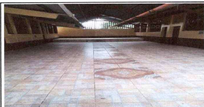
Foto 5: Finalización de Remozamiento salón usos multiples.
