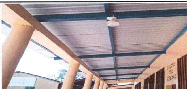
Foto 4: Finalización del sistema eléctrico.
