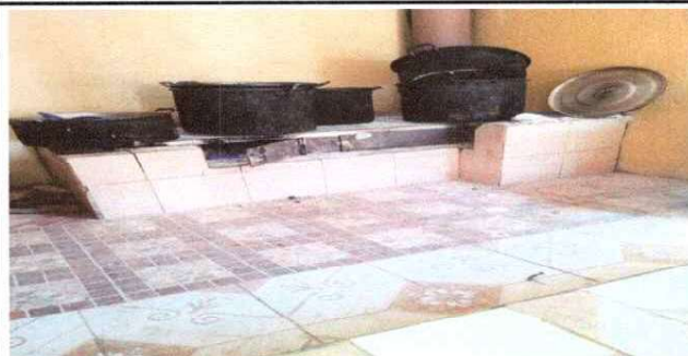
Foto 2: Finalización de remozamiento cocina.
