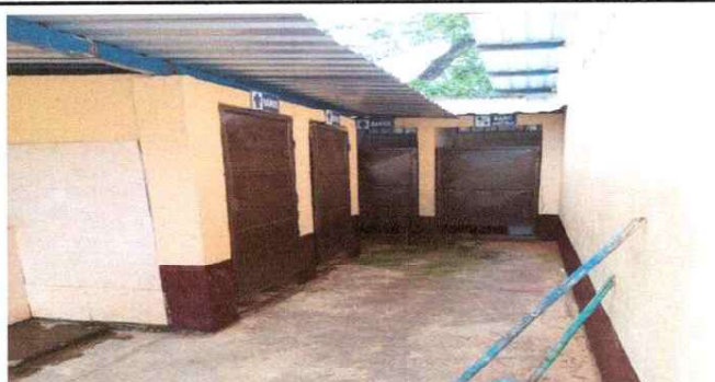
Foto 3: Finalización de remozamiento de puertas
