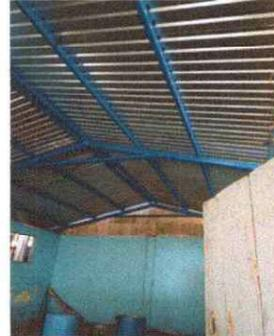
Foto 8: Se observa el cambio de la estructura de madera por metal
