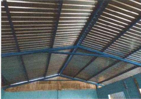
Foto7: Se observa el cambio de lamina del modulo de aula
