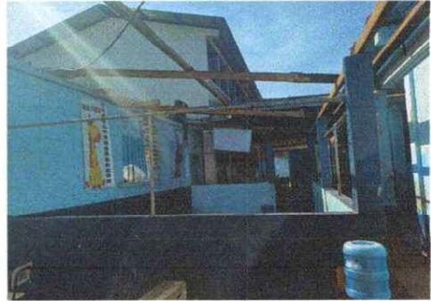
Foto 8: Se observa el cambio de la estructura de madera por metal
