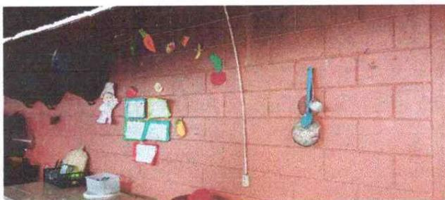
Foto 5. Se observa el mal estado de la pintura
