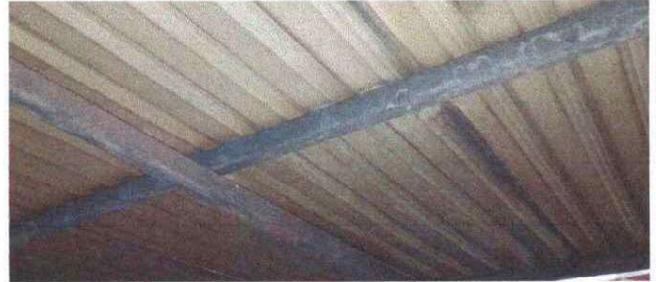
Foto 2. Se observa el mal estado de la estructura de metal de la cocina
