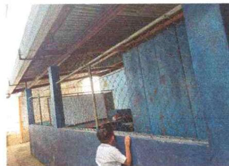
Foto 6. Se observa el mal estado de la malla existente
