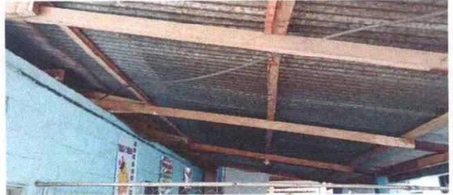
Foto 8. Se observa el mal estado de la estructura de madera en las aulas
