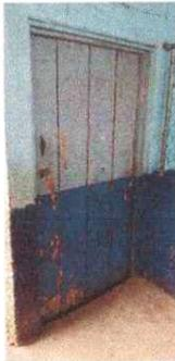
Foto 9. Se observa el mal estado de las puertas
