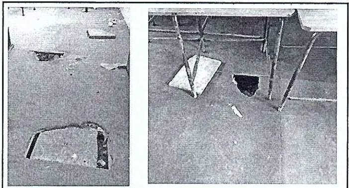
Foto 2: Se observa el mal estado del piso de los módulos prefabricados, urge sustitución
