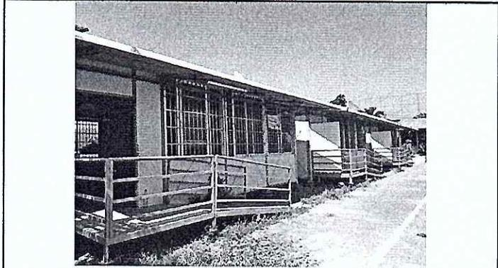
Foto 1: Se observan los 3 módulos prefabricados que necesitan sustitución de piso
