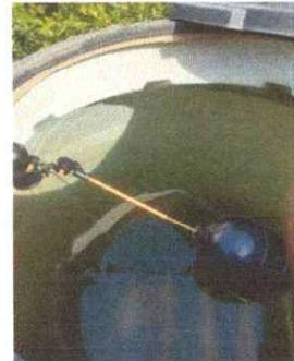
Foto 22: Se observa como quedo el rotoplas despues del cambio de accesorios
