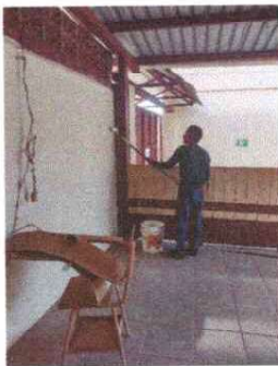
Foto 11: Se observa la aplicacion de pintura
