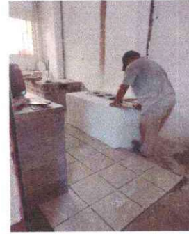
Foto 8: Se observa la colocacion de piso ceramico
