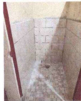
Foto 12: Se observa la sustitucion del sanitario
