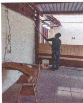
Foto 17: Se observa la aplicación de pintura
