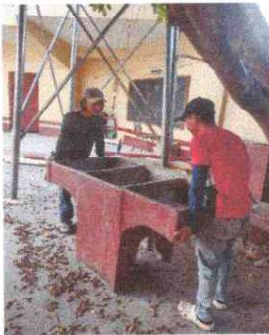
Foto 3: Se observa el cambio de la pila
