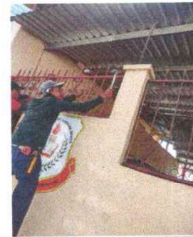
Foto 18: Se observa la colocación del balcon
