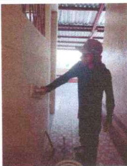
Foto 5: Se observa el proceso de repello en las paredes
