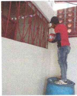
Foto 9: Se observa el mantenimiento a las ventanas
