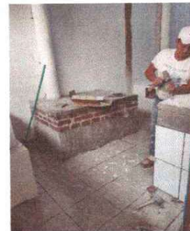
Foto 6: Se observa la colocacion de azulejo en el banco de cocina
