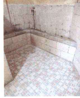
Foto 14: Se observa la reparación de migitorio
