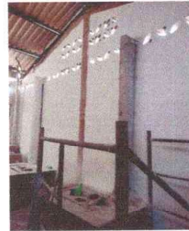
Foto 4: Se observa la reparacion de la chimenea
