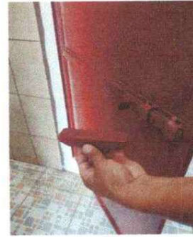
Foto 10: Se observa el mantenimiento a las puertas
