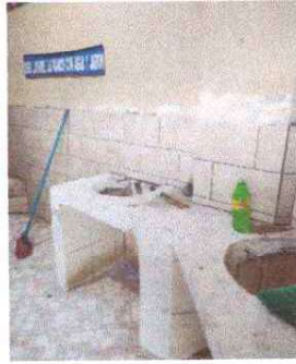
Foto 13: Se observa la reparación de lavamanos
