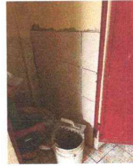
Foto 16: Se observa la colocación de azulejo en los baños
