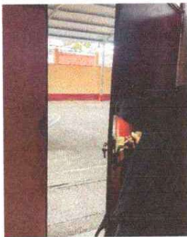
Foto 15: Se observa el mantenimiento a las puertas
