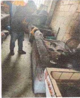
Foto 1: Se observa que las estufas se encuentran en mal estado.
