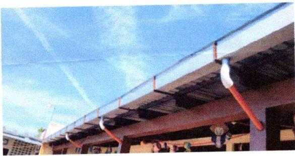
Foto 3: Se finalizó con la sustitución de canales.
