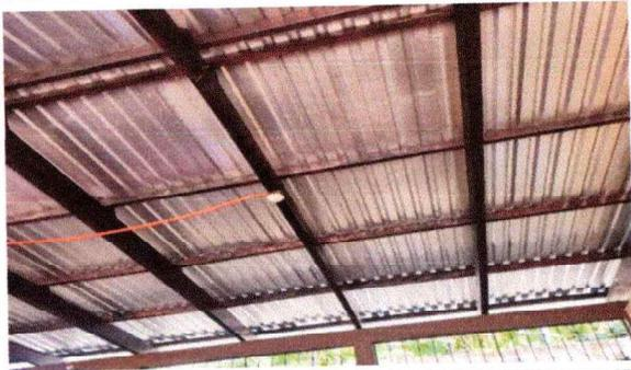
Foto1: Se finalizó con la colocación de la lámina troquelada calibre 26.
