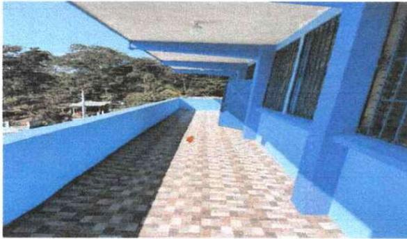
Foto 7: Se observa la instalación de el+B98:H117 piso antideslizante.
