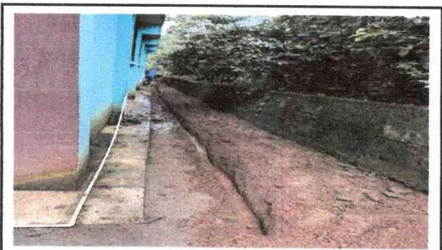
Foto 11: Se puede observar la instalación de la tubería principal.
