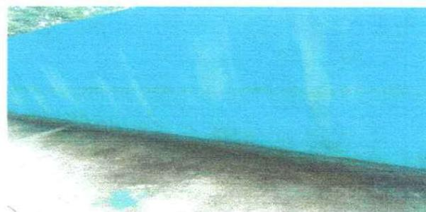
Foto 6: Se observa que los muros cuentan con pintura en mal estado
