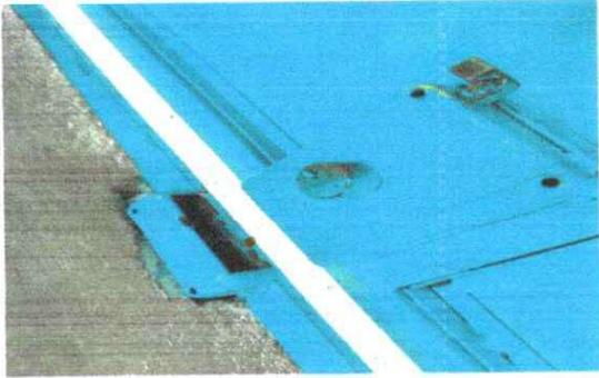
Foto 7: Se observa dañada la chapa y por eso la puerta ya no cierra.
