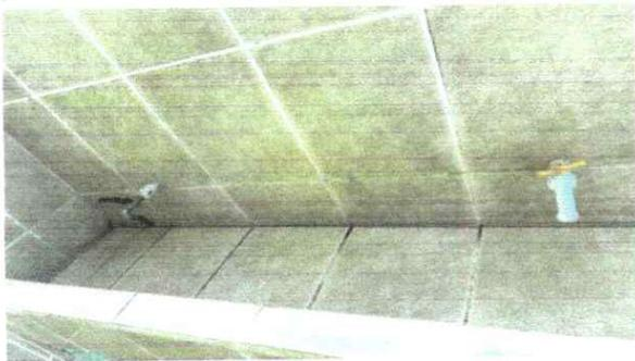
Foto 9: Debido al uso hay fugas y daño en los grifos, se considera necesaria la sustitución de los mismos
