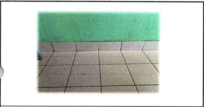
Foto 5: Reparación del zocalo en las aulas
