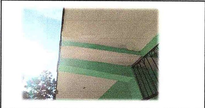
Foto 3:Reparación de junta sismica en losa de concreto
