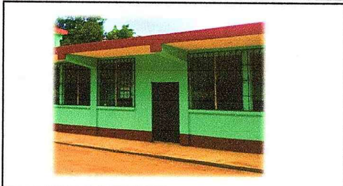
Foto 8: Reparación de puertas que estaban en mal estado
