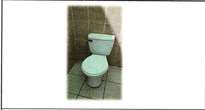
Foto1: Reparacion de sanitarios que utilizan los estudiantes
