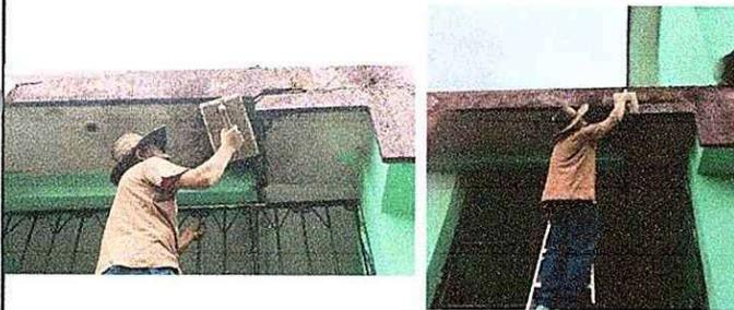
Foto 3: Reparación de junta sismica en losa de concreto
