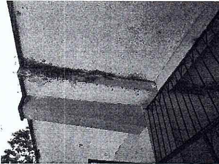
Foto 3: Se observa que módulo de la junta sísmica de losa de concreto
