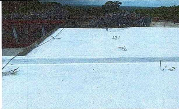
Foto1: Se observan la impermeabilización juntas sísmica
