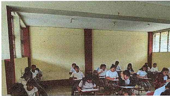
Foto 3: Arreglo, limpieza estructural de aulas y pintado
