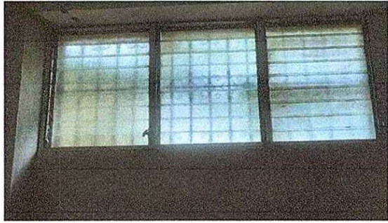
Foto 1: Se observan las paletas de vidrio completas
