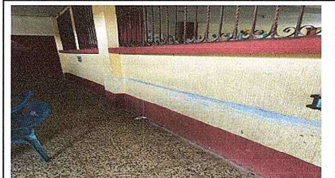
Foto 2: Se observa de sellados y pintado de muros exteriores
