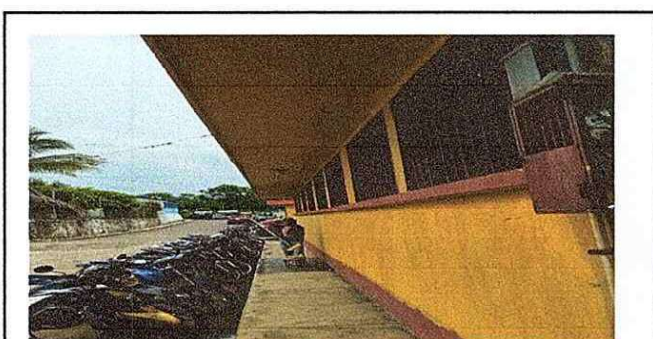
Foto 5: Se observa la Pintura Externa
