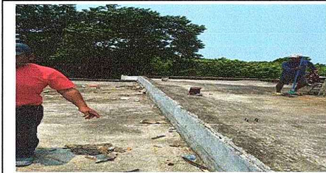
Foto 1: Se observan trabajos de losa limpieza y reparación Junta sísmica
