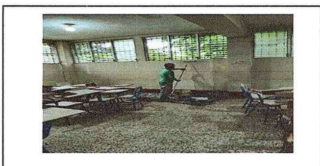
Foto 6: Se observa la Pintura interna
