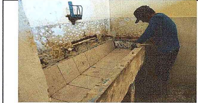
Foto 2: Se observa el picado para colocar cerámico
