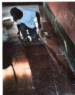
Foto 2: Se observa la colocacion de piso ceramico
