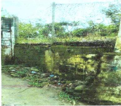
Foto 7: Se observa el mal estado del muro de contención
