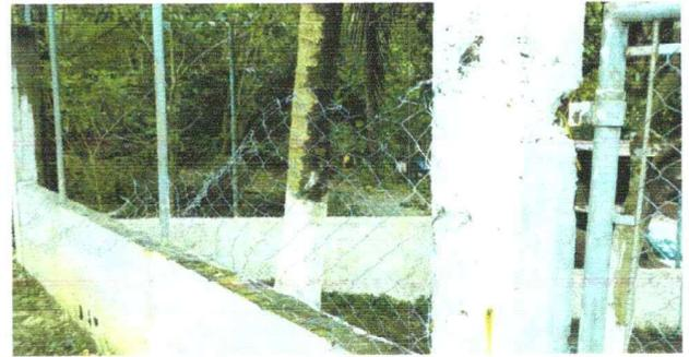
Foto 8: Se observa la necesidad de sustituir la malla galvanizada del muro
