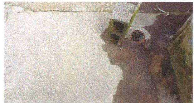
Foto 12: Se observa la necesidad de ampliar el tragante
