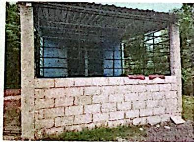
Foto 12: FOTOGRAFIA MEJORAMIENTO DE MURO EN EL AREA DE BAÑOS Y PILA
