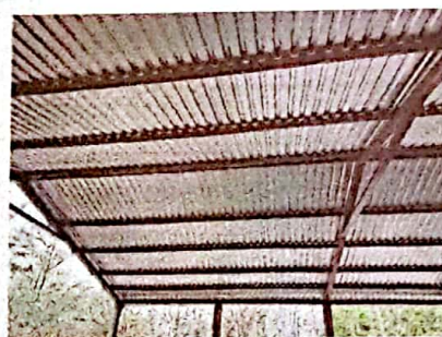
Foto 4: FOTOGRAFIA SUMINISTRO E INSTALACION DE ESTRUCTURA PORTANTE, LAMINA TROQUELADA CALIBRE 26
