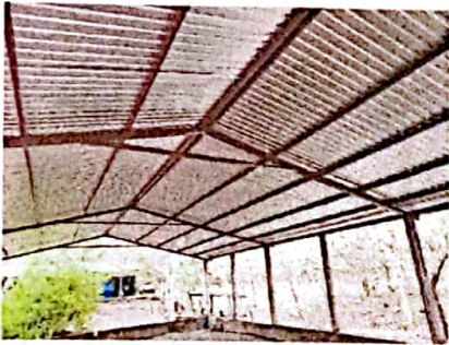
Foto 9: FOTOGRAFIA SUMINISTRO E INSTALACION DE ESTRUCTURA PORTANTE, LAMINA TROQUELADA CALIBRE 26
