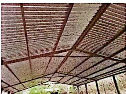
Foto 3: FOTOGRAFIA SUMINISTRO E INSTALACION DE ESTRUCTURA PORTANTE, LAMINA TROQUELADA CALIBRE 26
