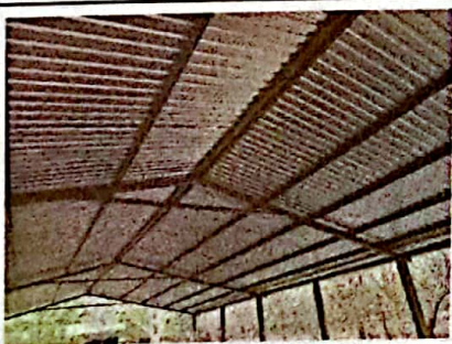
Foto 5: FOTOGRAFIA SUMINISTRO E INSTALACION DE ESTRUCTURA PORTANTE, LAMINA TROQUELADA CALIBRE 26
