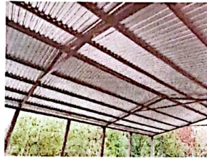
Foto 8: FOTOGRAFIA SUMINISTRO E INSTALACION DE ESTRUCTURA PORTANTE, LAMINA TROQUELADA CALIBRE 26
