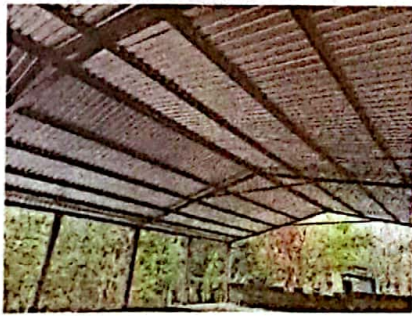
Foto 11: FOTOGRAFIA SUMINISTRO E INSTALACION DE ESTRUCTURA PORTANTE, LAMINA TROQUELADA CALIBRE 26
