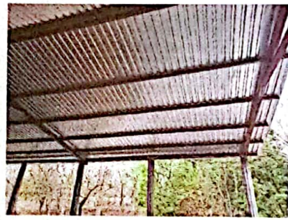
Foto 10: FOTOGRAFIA SUMINISTRO E INSTALACION DE ESTRUCTURA PORTANTE, LAMINA TROQUELADA CALIBRE 26
