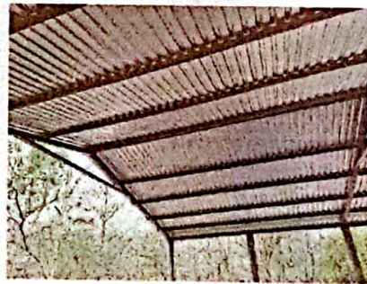
Foto 12: FOTOGRAFIA SUMINISTRO E INSTALACION DE ESTRUCTURA PORTANTE, LAMINA TROQUELADA CALIBRE 26
