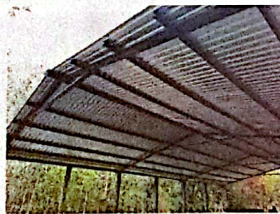
Foto 6: FOTOGRAFIA SUMINISTRO E INSTALACION DE ESTRUCTURA PORTANTE, LAMINA TROQUELADA CALIBRE 26
