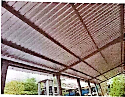
Foto 7: FOTOGRAFIA SUMINISTRO E INSTALACION DE ESTRUCTURA PORTANTE, LAMINA TROQUELADA CALIBRE 26
