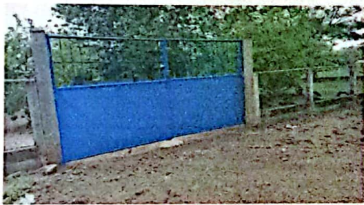
Foto 3: FOTOGRAFIA SUMINISTRO E INSTALACION PORTON DE INGRESO
