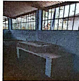
Foto 12: FOTOGRAFIA SUMINISTRO E INSTALACION DE ESTUFA RURAL
