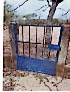
Foto 8: FOTOGRAFIA SUMINISTRO E INSTALACION DE PUERTA CON CHAPA
