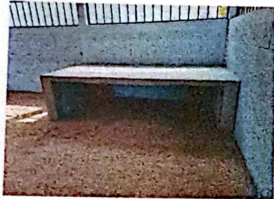
Foto 9: FOTOGRAFIA SUMINISTRO E INSTALACION MESA DE CEMENTO
