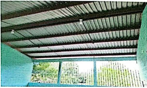
Foto 3: Se observa el cambio de la estructura de techo
