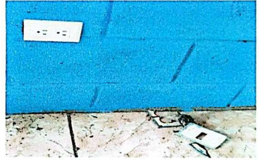
Foto 4: Se observa el trabajo del cambio del sistema eléctrico
