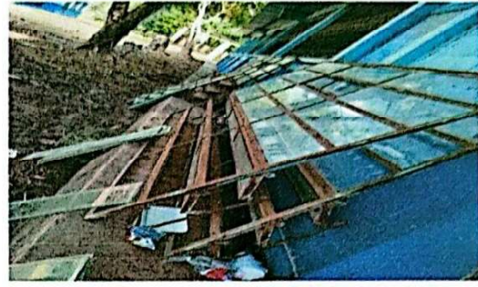
Foto 2: Se observa el trabajo para el cambio de la estructura de metal de los balcones.
