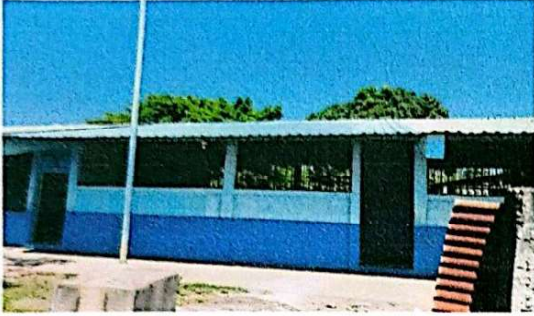
Foto1: Se observa el trabajo de cambio de lámina
