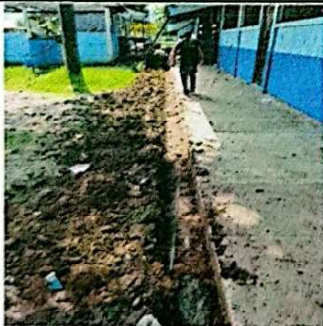
Foto 5: Se observa el trabajo de reparación de cuneta
