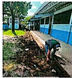
Foto 6: Se Observa el trabajo de reparación de cuneta
