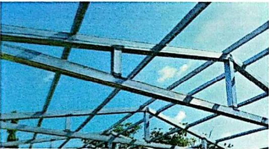
Foto 3: Se observa el trabajo para el cambio de la estructura de techo
