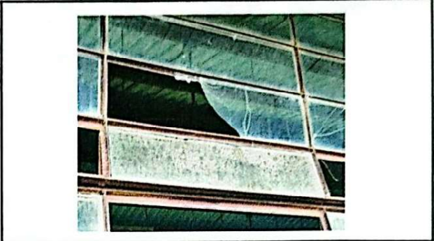
Foto 2: Se observa el mal estado de los balcones.
