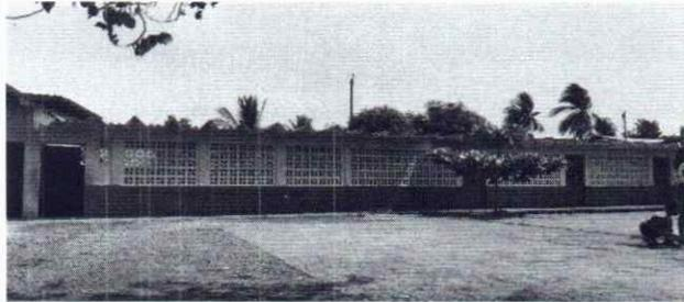
Foto 1: Se observa la necesidad de sustituir lámina existente y pintar los muros interior y exterior
