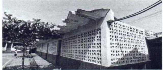
Foto 2: Se observa la necesidad de conformación de mojinete y conformación de estructura de soporte de metal
