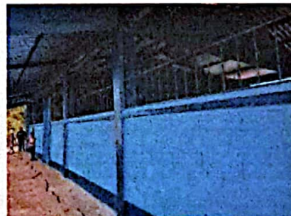
Foto 6: FOTOGRAFIA SUMINISTRO E INSTALACION DE BALCONES, PINTURA EN EL EXTERIOR DEL AULA
