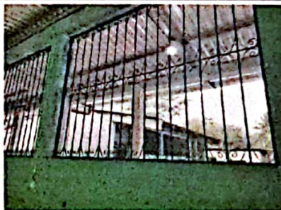
Foto 6: FOTOGRAFIA SUMINISTRO E INSTALACION DE BALCONES
