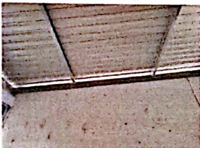
Foto 9: FOTOGRAFIA SUMINISTRO E INSTALACION DE ESTRUCTURA PORTANTE, LAMINA TROQUELADA CALIBRE 26
