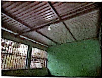
Foto 7: FOTOGRAFIA SUMINISTRO E INSTALACION DE ESTRUCTURA PORTANTE, LAMINA TROQUELADA, SISTEMA ELECTRICO
