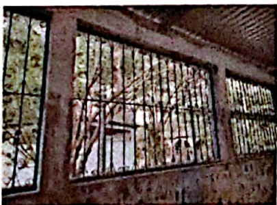
Foto 5: FOTOGRAFIA SUMINISTRO E INSTALACION DE BALCONES
