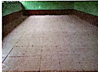
Foto 10: FOTOGRAFIA SUMINISTRO E INSTALACION DE PISO
