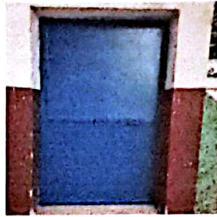
Foto 8: FOTOGRAFIA SUMINISTRO E INSTALACION DE PUERTA CON CHAPA
