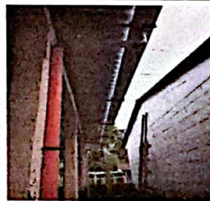
Foto 12: FOTOGRAFIA SUMINISTRO E INSTALACION DE CANAL, BAJADAS PLUVIALES
