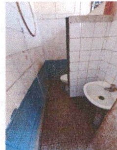
Foto 10: FOTOGRAFIA ESTADO ACTUAL DEL BAÑO
