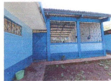
Foto 12: MEJORAMIENTO PISO DE CEMENTO EN EL PATIO
