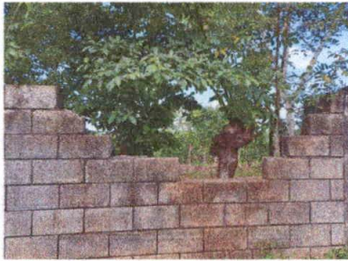
Foto 3: FOTOGRAFIA ESTADO ACTUAL DEL MURO PERIMETRAL
