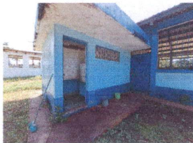
Foto 11: MEJORAMIENTO PISO DE CEMENTO EN EL PATIO
