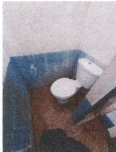
Foto 9: FOTOGRAFIA ESTADO ACTUAL DEL BAÑO
