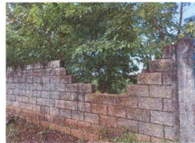
Foto 4: FOTOGRAFIA ESTADO ACTUAL DEL MURO PERIMETRAL
