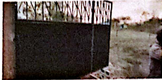
Foto 8: FOTOGRAFIA SUMINISTRO E INSTALACION DE PORTON
