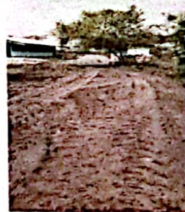
Foto 6: FOTOGRAFIA SUMINISTRO Y APLICACIÓN DE BALASTRO
