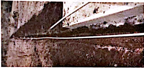
Foto 3: FOTOGRAFIA SUMINISTRO E INSTALACION LINEA DE CONDUCCION AGUA POTABLE
