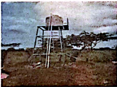
Foto 5: FOTOGRAFIA SUMINISTRO E INSTALACION DEPOSITO DE AGUA MAS ESTRUCTURA DE METAL
