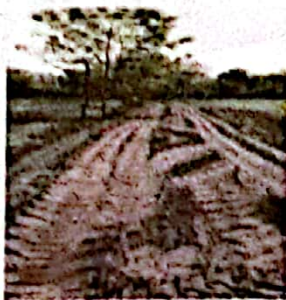
Foto 11: FOTOGRAFIA SUMINISTRO Y APLICACIÓN DE BALASTRO
