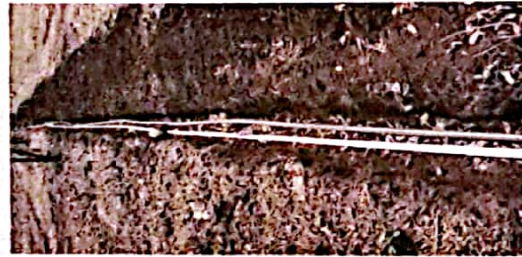
Foto 4: FOTOGRAFIA SUMINISTRO E INSTALACION DE LINEA ELECTRICA
