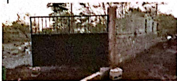
Foto 10: FOTOGRAFIA MEJORAMIENTO MURO PERIMETRAL
