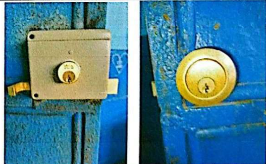
Foto 6: Se observa que las 5 chapas de aulas en mal estado fueron sustituidas. 29/11/2024
