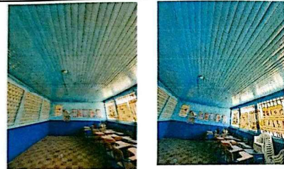
Foto 9: Se observa el machimbre en las 4 aulas reparado y pintado. 29/11/2024
