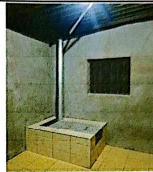
Foto 2: se observa que la sustitucion del viejo poyeton por estufa rural completa, con su plancha y chimenea. 29/11/2024
