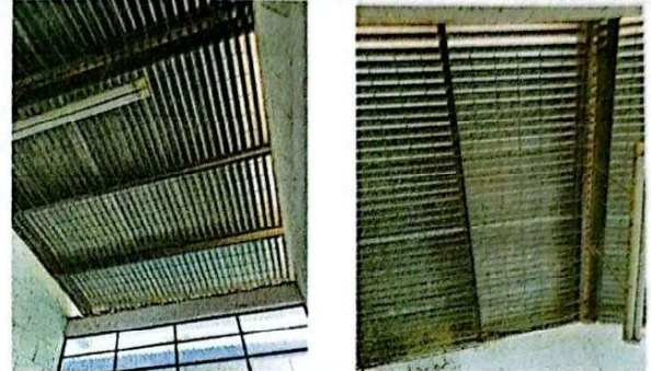
Foto 8: Se observa que la estructura de soporte de metal Modulo 4 fue, lijada y se aplicó pintura
