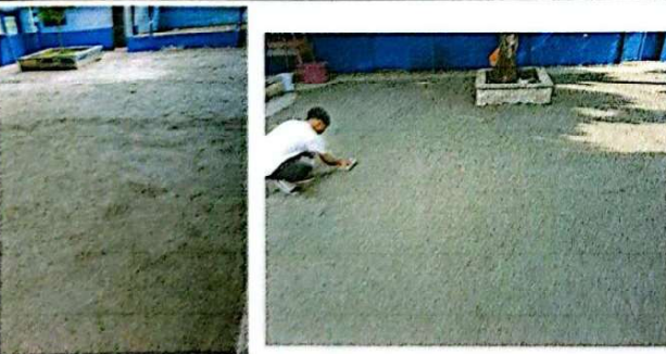
Foto 11: Se observa torta de concreto de patio 1 fue sustituida. 29/11/2024
