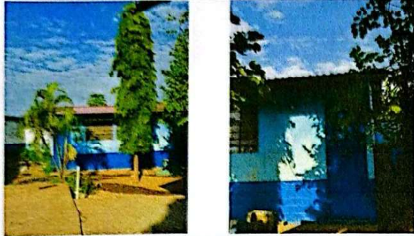
Foto 7: Se observa la lamina troquelada aluzink calibre 26 ya montada. 29/11/2024
