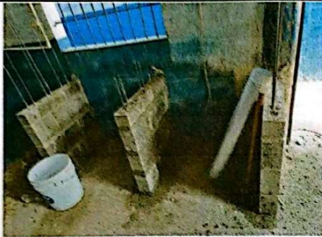
Foto 1: Se puede observar que el proceso del banco de trabajo. 11/11/2021
