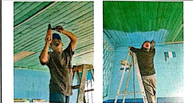
Foto 9: Se observa el mantenimiento y reparacion del machimbre en las 4 aulas. 26/11/2024
