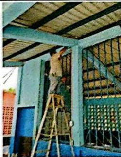
Foto 5: Se observa la sustitución completa del sistema electrico en aulas. 13/11/2024
