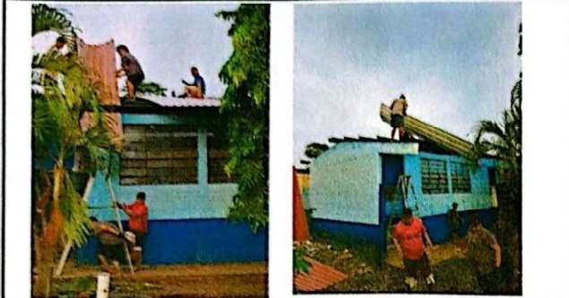
Foto 7: Se observa el proceso de sustitución de la lamina por lamina troquelada calibre 26. 14/11/2024
