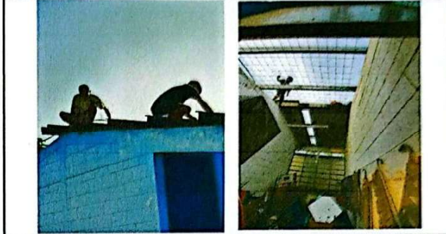
Foto 8: Se observa el mantenimiento que le dan a la estructura de metal, lijado, cepillado y pintura del modulo 4 12/11/2024
