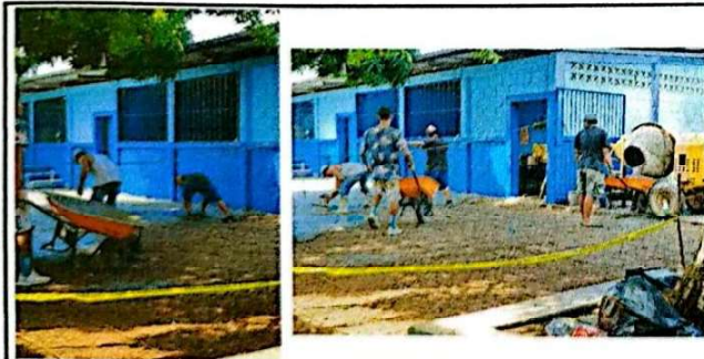
Foto 11: Se observa la sustitución de la torta de concreto del patio 1 06/11/2024
