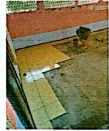
Foto 4: Se observa la instalación del piso cerámico 15/11/2024
