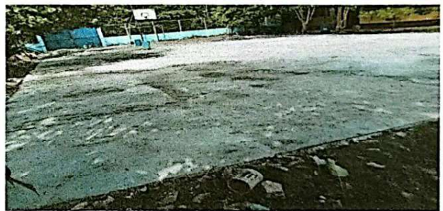
Foto 4: Se observa el trabajo dfinalizado de la cancha polideportiva
