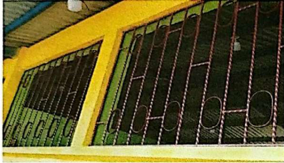
Foto1: Se observa el trabajo finalizado del mantenimiento a los balcones.
