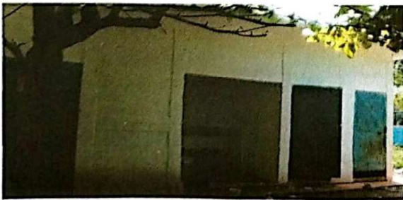
Foto 5: Se observa el mantenimiento finalizado de paredes de los baños
