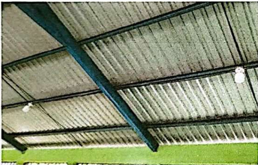
Foto 3: Se observa el trabajo finalizado de sistema eléctrico.
