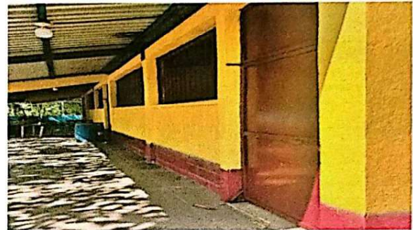
Foto 2: Se observa el trabajo terminado de pintura de paredes.
