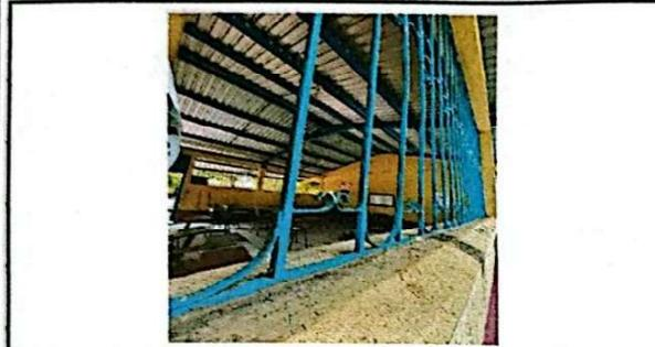
Foto 1: Se observa el deterioro por la corrosión que tiene los balcones y la necesidad de darle mantenimiento para evitar el deterioro total.
