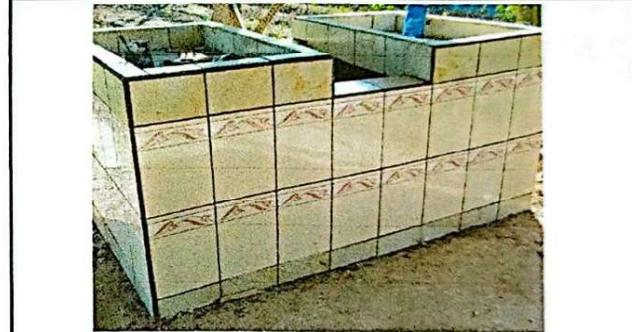
Foto 4: Se observa la pila de agua sustituida por pila de concreto y azulejo. 29/11/2024
