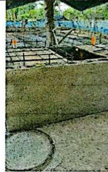
Foto 4: Se observa que el tanque de agua esta en proceso para ser pila de agua de concreto y azulejo. 19/11/2024
