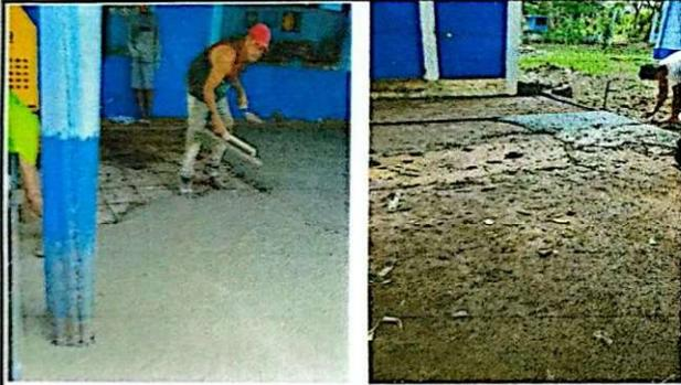
Foto 3: Se observa que la plancha de concreto esta en proceso de fundición. 16/11/2024
