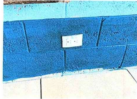
Foto 2: Al módulo 1, 3 y 4 se le sustituyo el sistema eléctrico.
