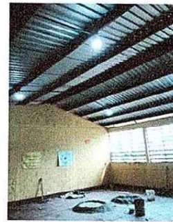
Foto 4: se realizo el cambio de la estructura de metal del techo de la cocina
