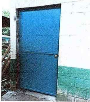
Foto 3: Se realizo la sustitución de la puerta.
