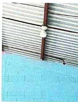
Foto 5: se realizo el cambio del techo de la cocina
