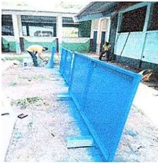
Foto 3: Se procede a realizar la sustitución de las puertas.
