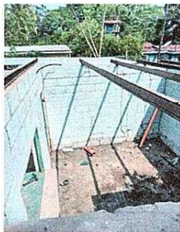
Foto 5: Se procede a realizar el cambio del techado de la cocina.
