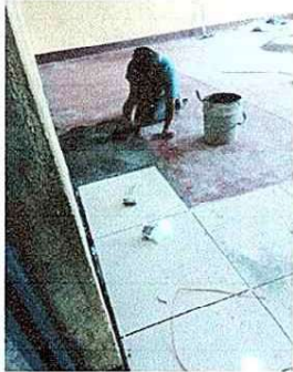
Foto 1: Se procede a realizar la colocación del piso ceramico.
