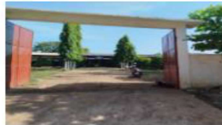
Foto 10: Se observa la entrada a la escuela ya arreglada con la torta de cemento que se le colocó el ingreso ya es viable.
