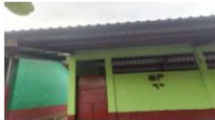
Foto 8: Se observa las costaneras nuevas colocadas ya en la finalización del Remozamiento.
