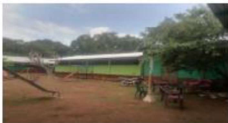
Foto 7: Se observa el trabajo de techado finalizado en el módulo de aulas.
