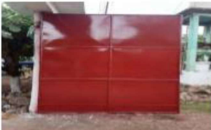
Foto 9: Trabajo de arreglo y pintura del portón finalizado.
